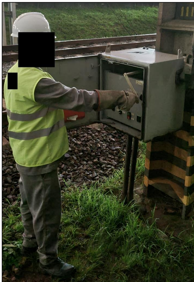
Figura 35 – Seccionamento manual da chave 11P
