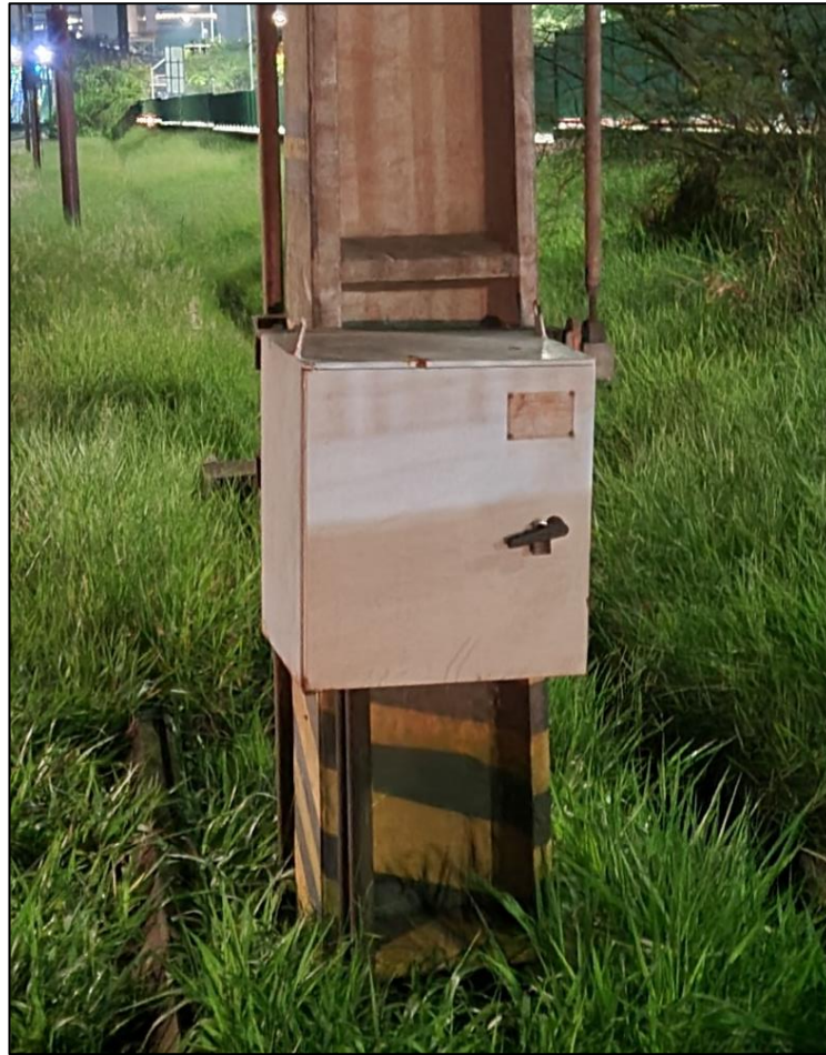
Figura 38 – Seccionadora sem dispositivo de bloqueio e sem placa de sinalização
