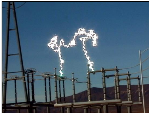
Figura 3 – Arco elétrico numa abertura de seccionadora de subestação
