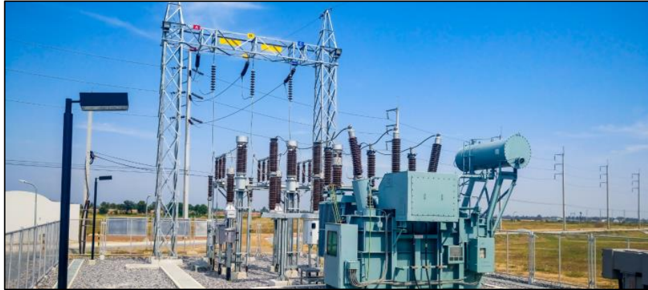
Figura 22 – Subestação Rebaixadora
