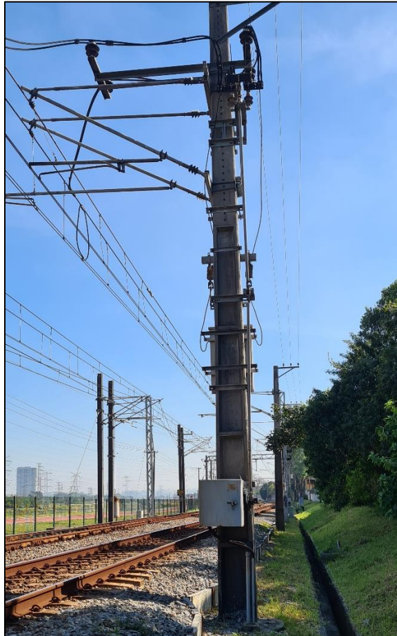
Figura 29 – Chave Seccionadora
